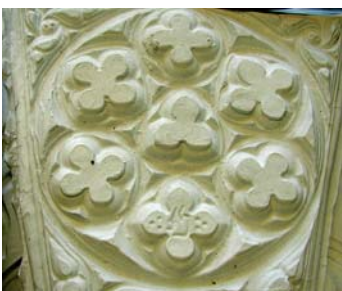
8–9. kép. Vakmérműves tetőcsempe kiegészítése és a csempéhez készített szilikongumi-negatív (Visegrád, királyi palota, Grósz Zsuzsanna munkája)
